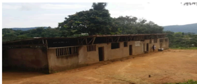
Schulgebäude in Ngambé
